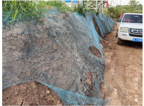
临时土方覆盖②
