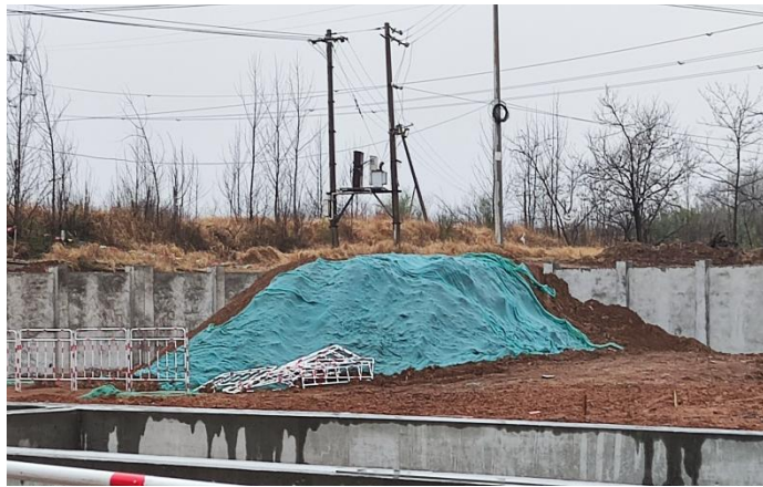
临时土方覆盖①
