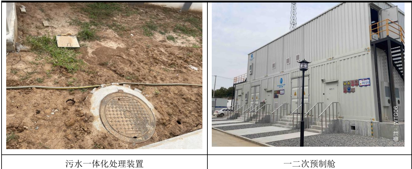
图4-3 本项目110kV升压站建设情况
