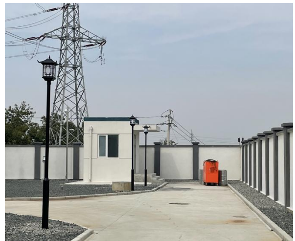
升压站内地面硬化
