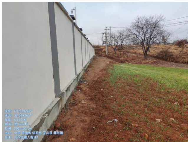
站外临时占地绿化
