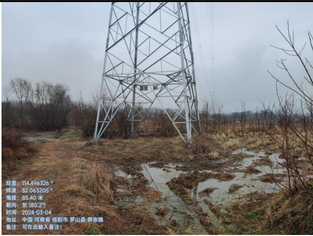
G14 杆塔周边恢复成灌草地
